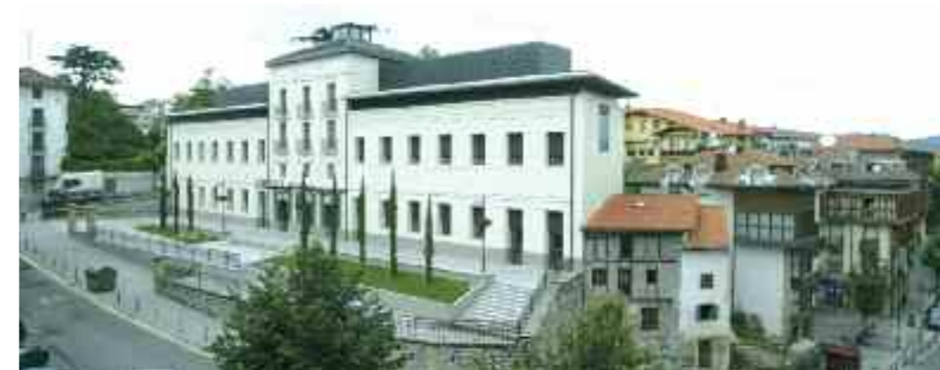
Figura 2. El Museo Romano Oiasso una vez finalizadas las obras. Foto: Ayuntamiento de Irun.
