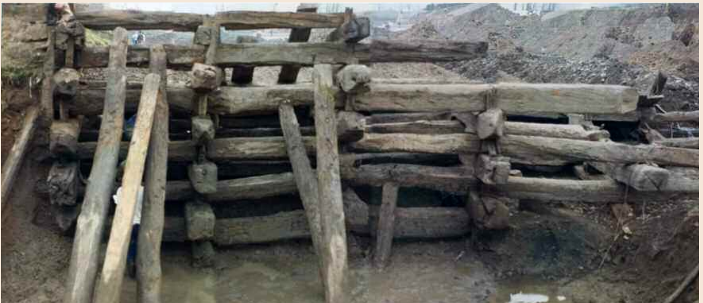
Igartzako (Beasain) zurezko presaren zatia, uholdeak saihesteko bideratze-lanekin desegin gabe zegoena. Irudiaren ezkerrean elastiko zuria daraman pertsonak, egituraren neurriaren berri ematen du. Tramo de la presa de madera de Igartza, Beasain, que no había sido desmantelado con las obras de encauzamiento para evitar inundaciones. La persona con camiseta blanca en la izquierda de la imagen, da idea de la altura de la estructura
