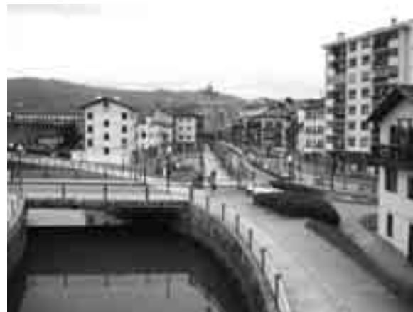
Fig. 4. Vista actual de la calle Santiago de Irun
