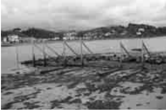
Fig. 16. El varadero y muelle del Club de Vela de Hendaia (2004)
