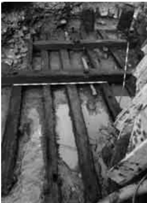
Fig. 8. Estructura de madera del varadero del puerto romano de Santiago
