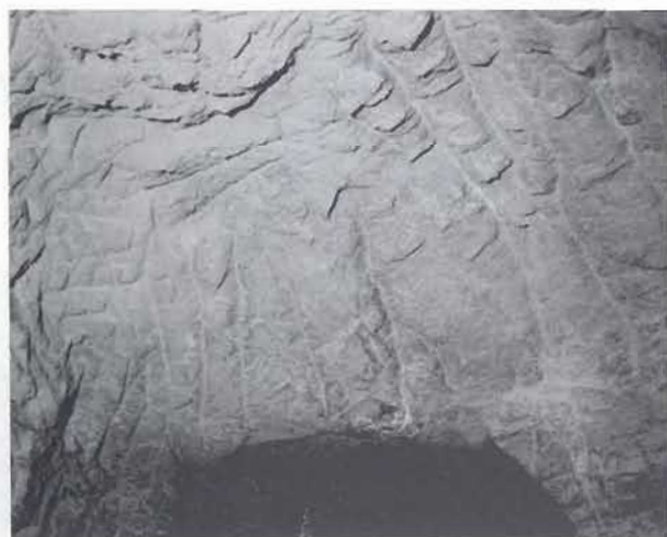
Figura 16. Detalle de la unión a diferentes alturas de dos tramos de la galería de drenaje. Foto Felix Ugarte Elkarte.
