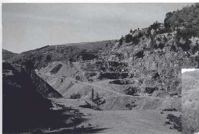
Figura 3. La cantera a cielo abierto de Santa Bárbara.
